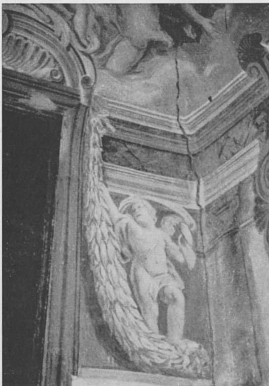
Fig. 5 - Castello di Rota. Lesioni nella volta e nelle murature laterali di una sala del primo piano. (Foto G. Cirilli)
