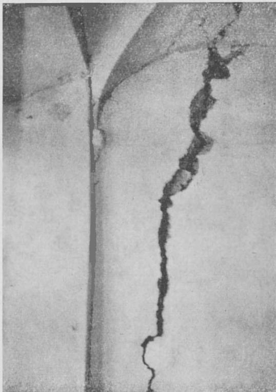
Fig. 6 - Castello di Rota. Grave lesione nella parete della scala che conduce dal 1° al 2° piano. (Foto G. Cirilli)
