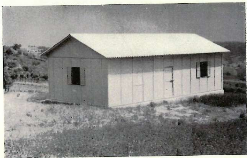
Osservatorio geomagnetico di Corinaldo - Padiglione per le misure magnetiche assolute costruito con materiali amagnetici.
